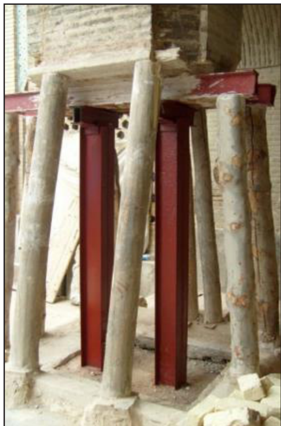
تصویر ۸. نصب ستون‌های جدید (عکس از: رزازی و ملکی).
