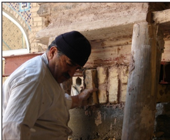
تصویر ۱۰. اتصال (مهر کردن) ستون جدید به سازه قدیم (عکس از: رزازی و ملکی).
