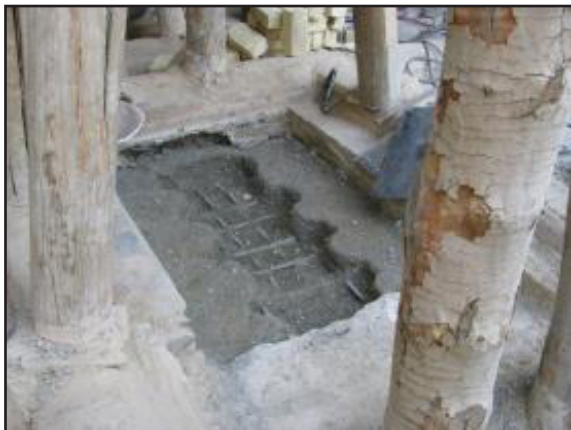
تصویر ۷. احداث شالوده برای اجرای ستون جدید (عکس از: رزازی و ملکی).
