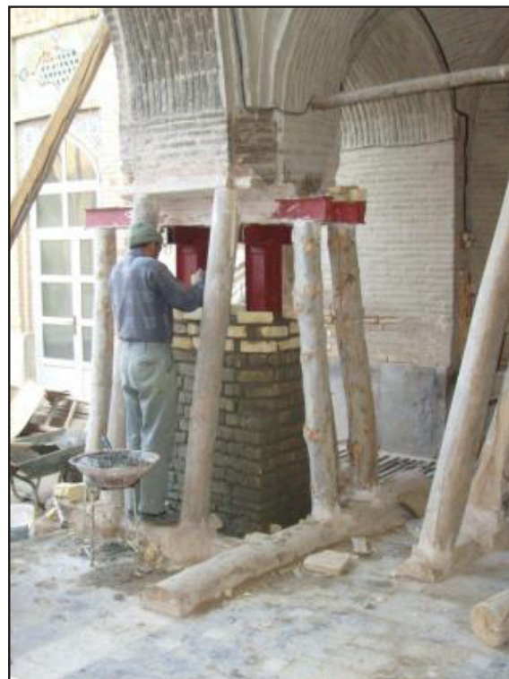
تصویر ۹. اجرای سفت‌کاری ستون آجری پیرامون ستون‌های جدید (عکس از: رزازی و ملکی).
